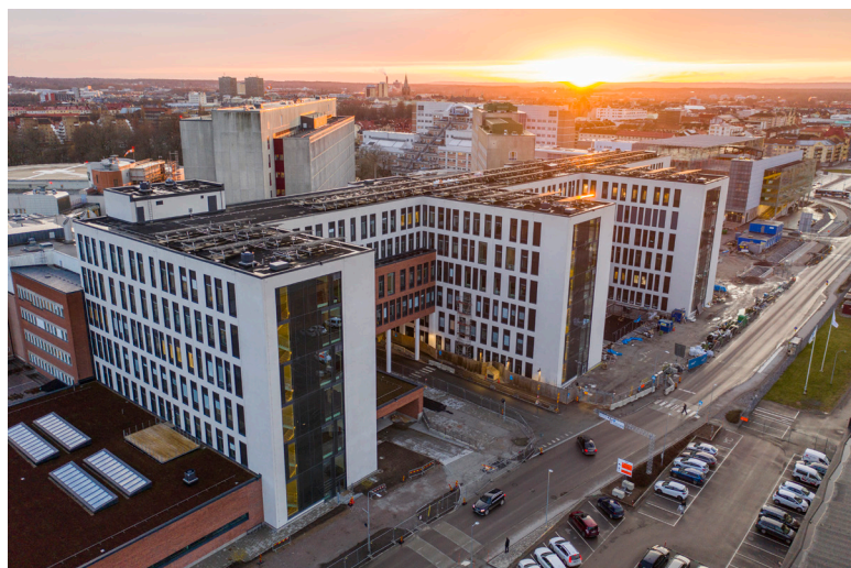
För Örebro Universitetssjukhus är hållbarhet viktigt och energieffektivitet avgörande. Man valde därför att nyttja det nybyggda garaget på ett innovativt sätt för en solcellsanläggning.
