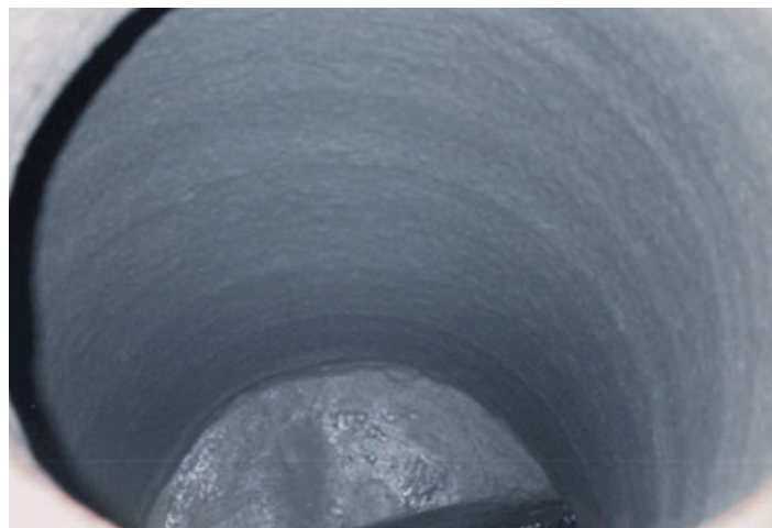
Renoverad brunn – tät och långlivad.
