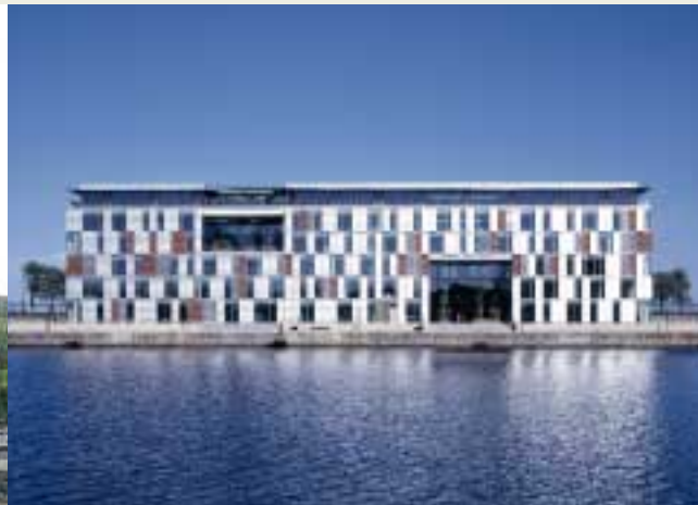
Foto: Henrik Ottosson FIH-huset, Köpenhamn.
