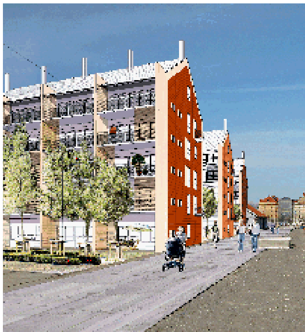
I Sundsvall bygger NCC Sveriges första femvåningshus helt i trä. Det är ett unikt projekt där en ny produktionsteknik används. Golv och väggheter av massivt trä byggs färdigt i fabrik. Det är också första bygget av bostadslägenheter i Sundsvall sedan 1990. White arkitekter står bakom ritningarna. 3D-illustration: White arkitekter
