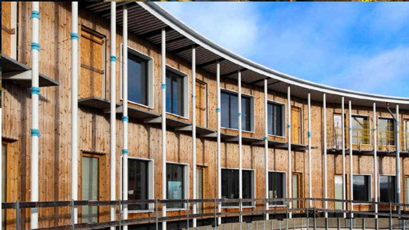
Fasaderna är monterade, och det silverfärgade kalziptaket tar form och kommer att vara färdigt på våren 2024.
